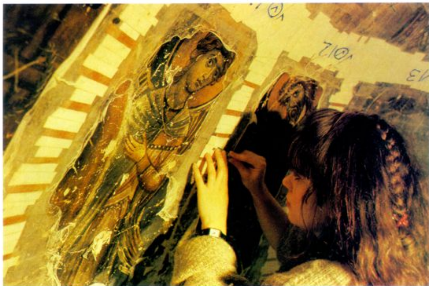
Οι τοιχογραφίες του τρούλου κατά τη διάρκεια των εργασιών αποκατάστασής τους.
