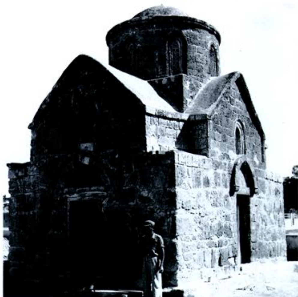
Ο ναός του Αγίου Ιακώβου στο Τρίκοιμο. Κτίστηκε το 14ο αιώνα και αποτελεί δείγμα βυζαντινής αρχιτεκτονικής που έχει ενσωματώσει δυτικά στοιχεία, όπως τους ορθογωνισμένους περσολίθους και τα οξυγώνια τόξα. Με την εισβολή ο ναός λεηλατήθηκε και εκλάπησαν οι εικόνες του.
