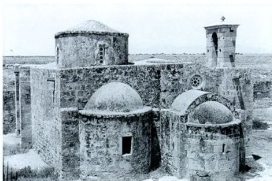
Η εκκλησία της μονής της Παναγίας της Αυγαΐδας στη Μηλιά Αμμοχώστου, 14ος αιώνας. Κατεδαφίστηκε ολοσχερώς για τη διάνοξη δρόμου. Οι τοιχογραφίες αφαιρέθηκαν ή καταστράφηκαν κατά τη διάρκεια της κατεδάφισης.
