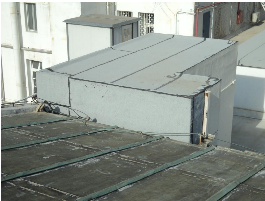
Φωτογραφία 18: Το προσκείμενο κτίσμα (νοτιοανατολική άποψη)
