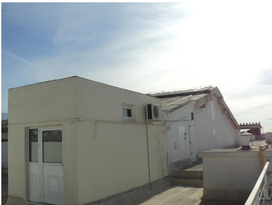
Φωτογραφία 17: Το προσκείμενο κτίσμα (βορειοδυτική άποψη)
