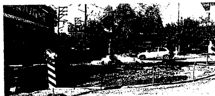
Ο υπό διαμόρφωση κόμβος στην οδό Ευβοίας
