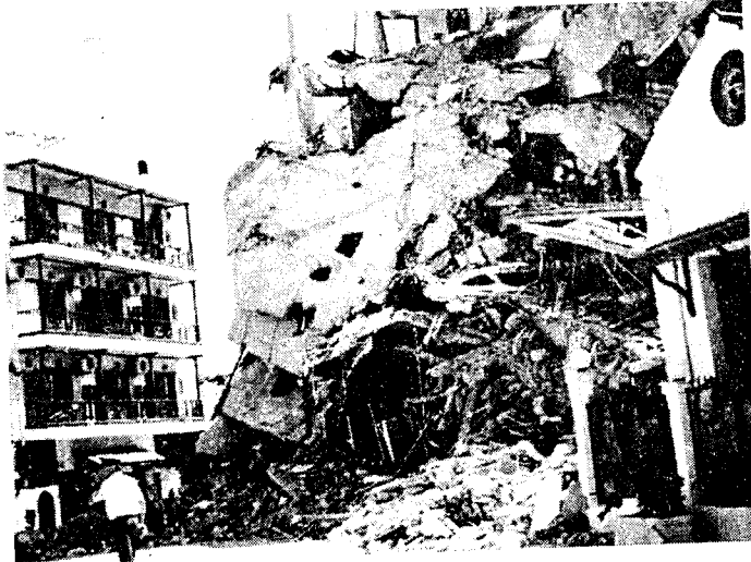
Ό,τι απέμεινε από την πολυκατοικία της Δεσποτοπούλου, την οποία είχαν χαντακώσει κατασκευαστικές αστοχές. Δεξιά, η αίτηση του περιφερειάρχη προς Χουλιαράκη
