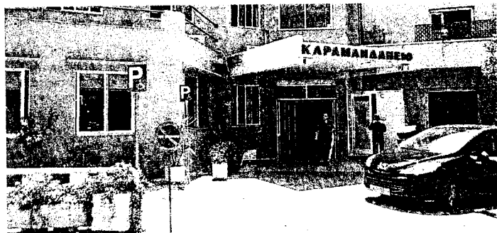
Η ανάφλεξη στο σύστημα θέρμανσης αποτέλεσε την αφορμή προκειμένου να αναδειχθούν λειτουργικά ζητήματα του Καραμανδανείου
