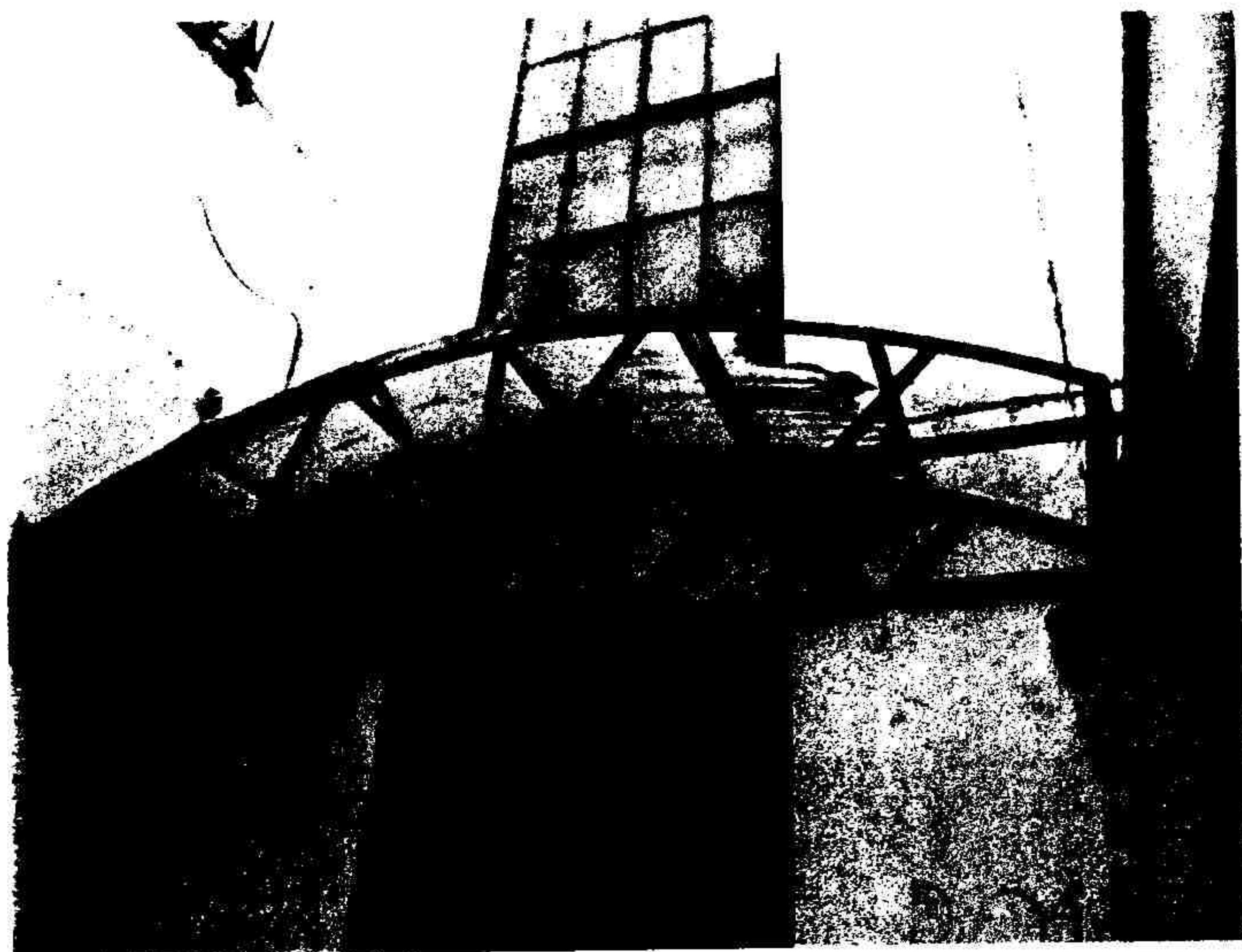
Φωτ. 21: Η είσοδος του παλαιού διδακτηρίου με το κατεστραμμένο στέγαστρο. Η κάθετη ρωγμή δεξιά είναι η ένωση παλαιού με νέο διδακτήριο.
