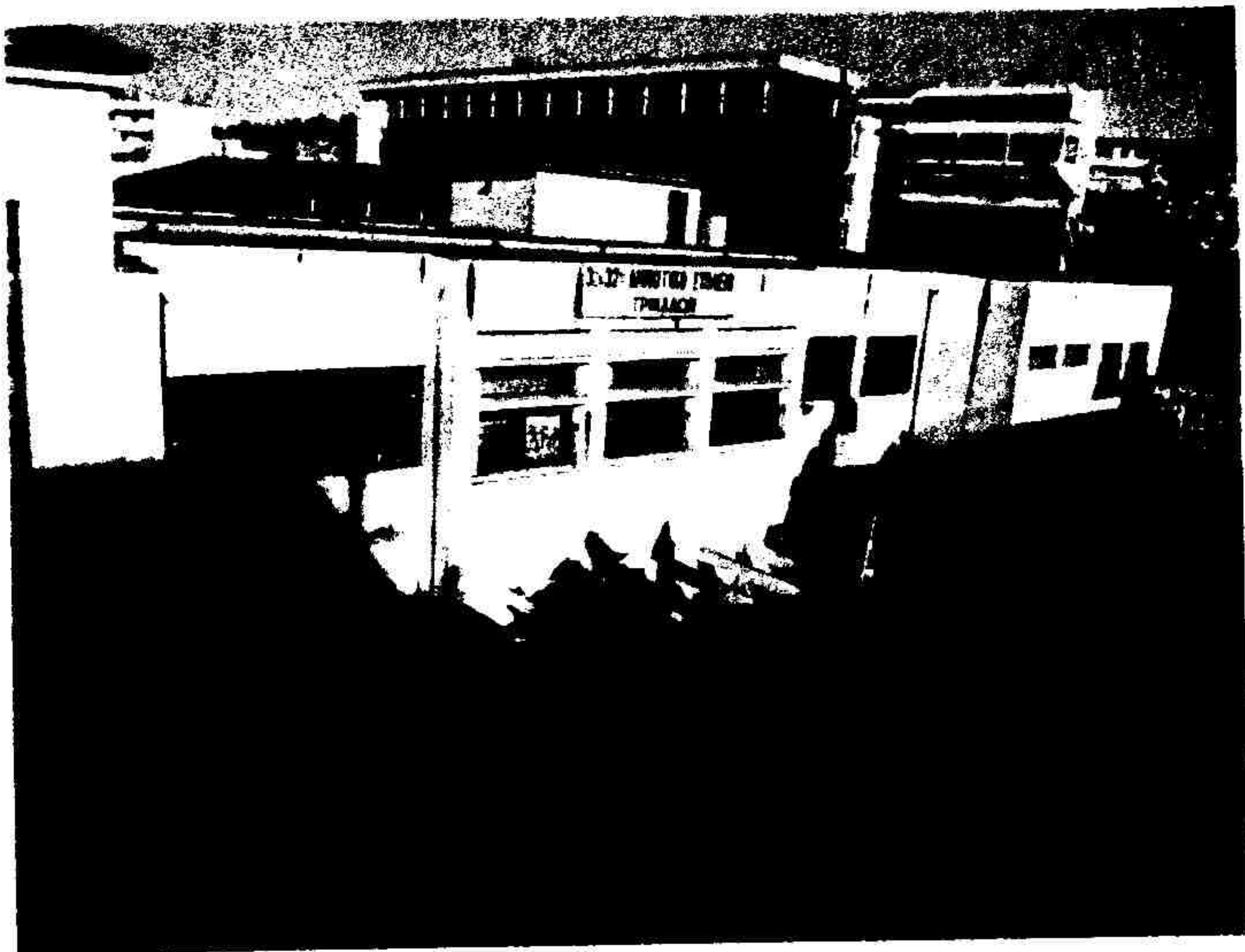
Φωτ. 49: Ολόκληρη η κατασκευή. Πάνω από αυτή προτείναμε να τοποθετηθεί κεκλιμένο στέγαστρο, για την απορροή των νερών της βροχής, προστατεύοντας από τη διάβρωση το σκυρόδεμα και την δυνατότητα να κυλούν οι μπάλες κάτω για να μην αναγκάζονται οι μαθητές, με κίνδυνο της ζωής τους, να ανεβαίνουν για να τις κατεβάσουν.
