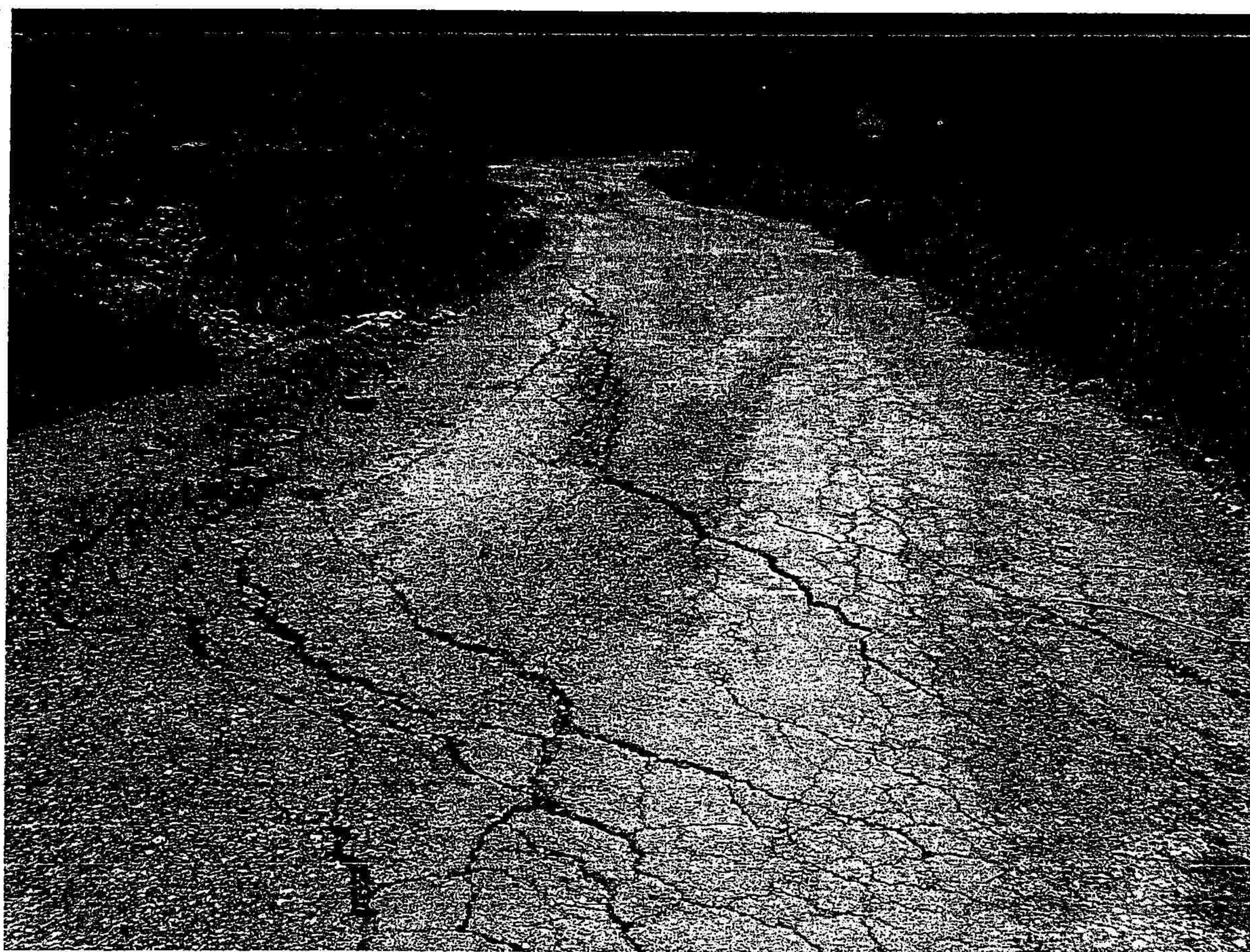
Φώτο 2 - Καθίζηση επαρχιακού δρόμου (Σπαρτιά)
