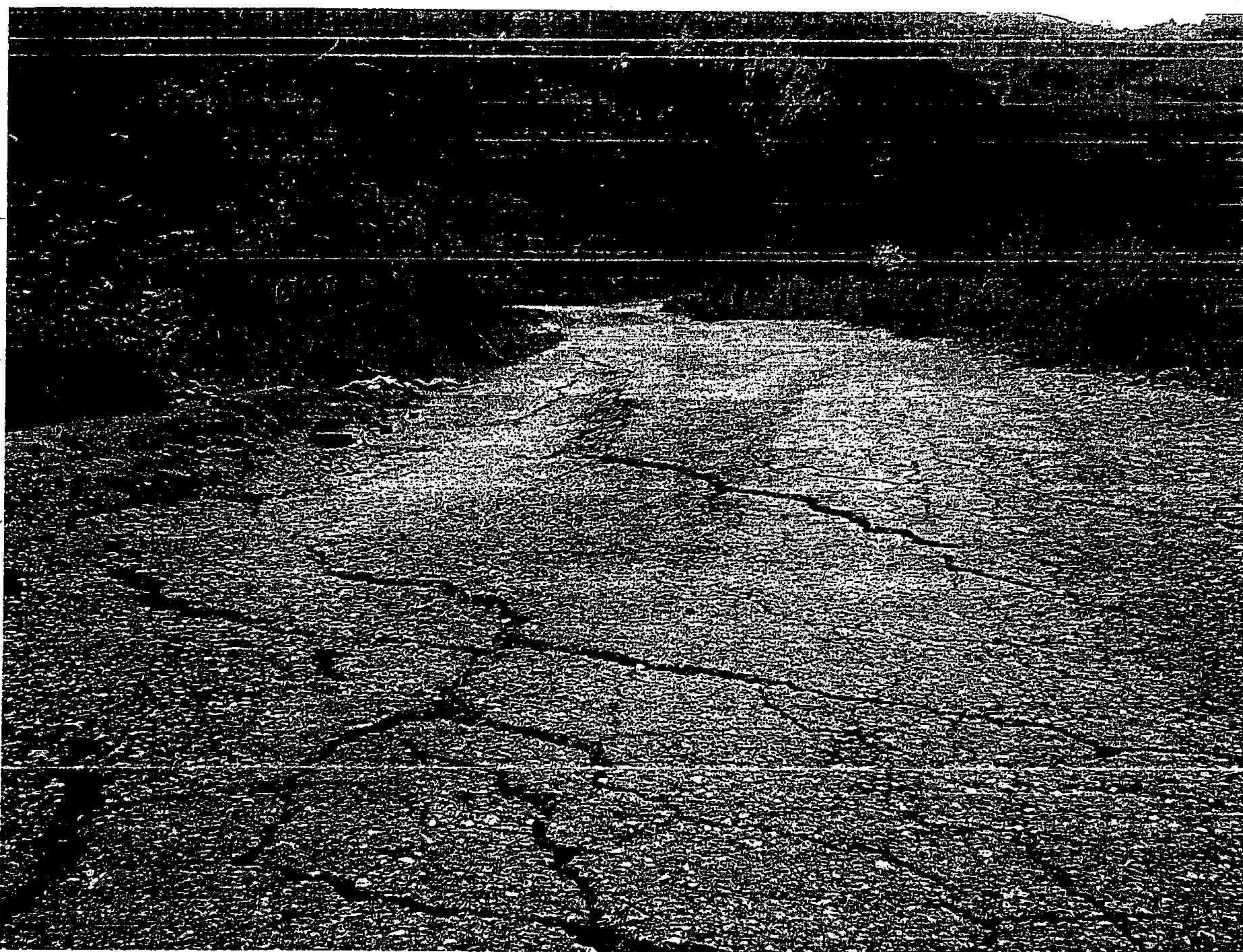
Φώτο 1 - Καθίζηση επαρχιακού δρόμου (Σπαρτιά)
