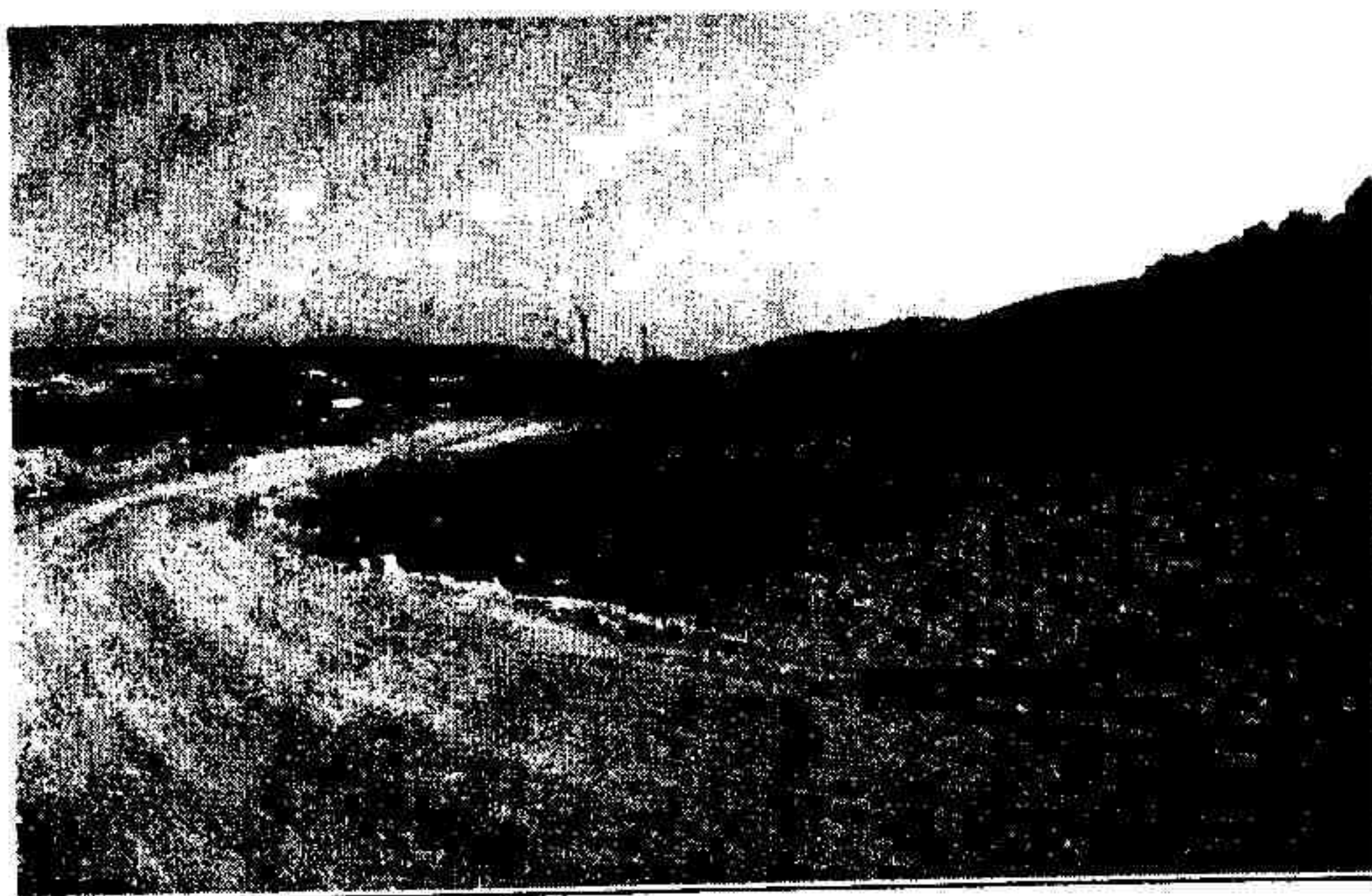
Εικόνα 4. Επιχωμάτωση της εκβολής για τη διαμόρφωση δρόμου.
