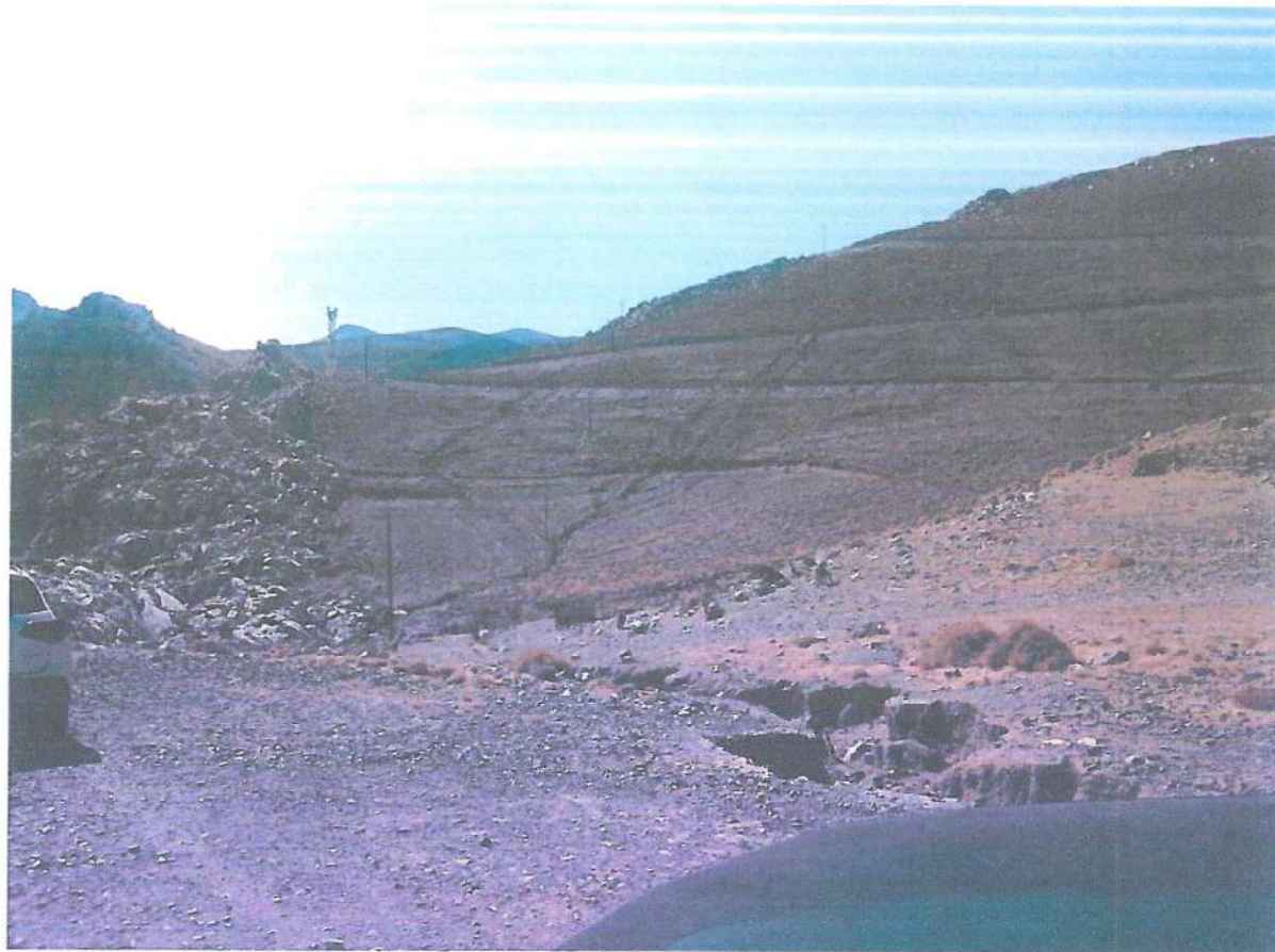
Φωτογραφία B2.3 - Γενική άποψη του οδικού τμήματος στην περιοχή της δεύτερης εκτροπής.
