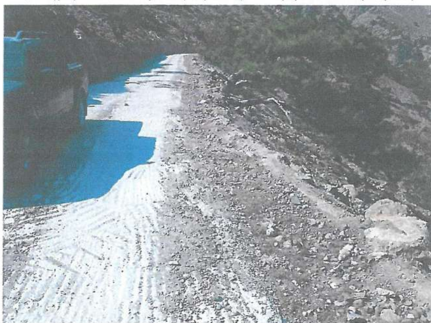
Φωτογραφία Γ4 - Περιορισμένο πλάτος κυκλοφορίας σε σχέση με διερχόμενο όχημα.
