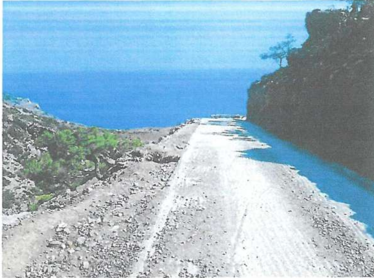
Φωτογραφία Γ1 - Χωματόδρομος σε εκτεθειμένο οδικό τμήμα με απότομο πρηνές.
