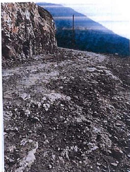
Φωτογραφία Γ7 - Χαλαρά υλικά και ανωμαλίες σε καμπύλο τμήμα του δρόμου.
