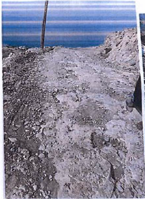
Φωτογραφία Γ6 - Βραχύδικες εξάρσεις και ανωμαλίες στο οδόστρωμα.
