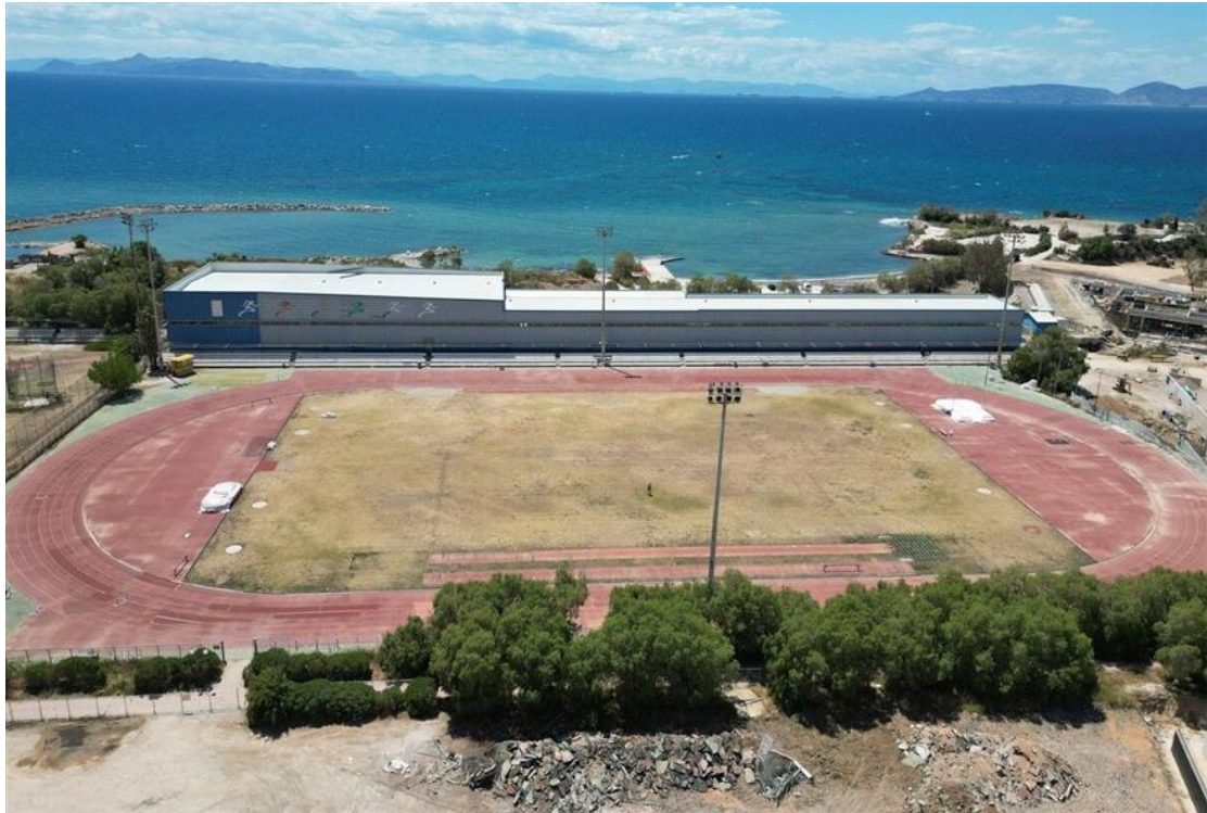
Άγιος Κοσμάς: Πανοραμική άποψη με εμφανή τα σημάδια εγκατάλειψης. Φωτογραφία Κώστας Ασημακόπουλος / ethnos.gr
