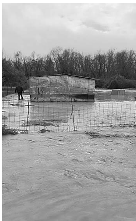
Κατά τη διάρκεια των ισχυρών βροχοπτώσεων, με τις σταβλικές εγκαταστάσεις στην Ακροποταμιά να έχουν πλημμυρίσει
