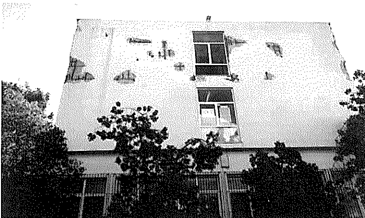
Οι σοβαρές φθορές στο Εργατικό Κέντρο Ηρακλείου αποτελούν κίνδυνο-θάνατο για πεζούς και μαθητές.
