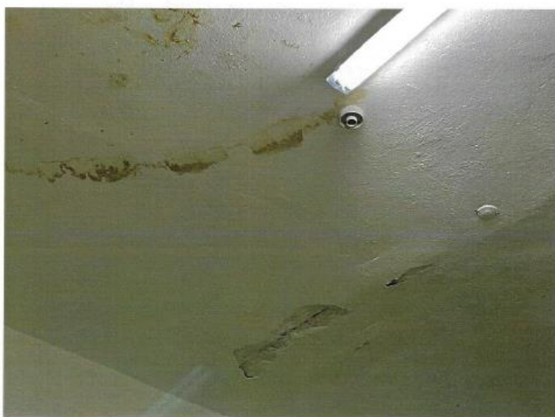
Εικ.4: Εισροή όμβριων υδάτων σε ηλεκτρολογική εγκατάσταση
