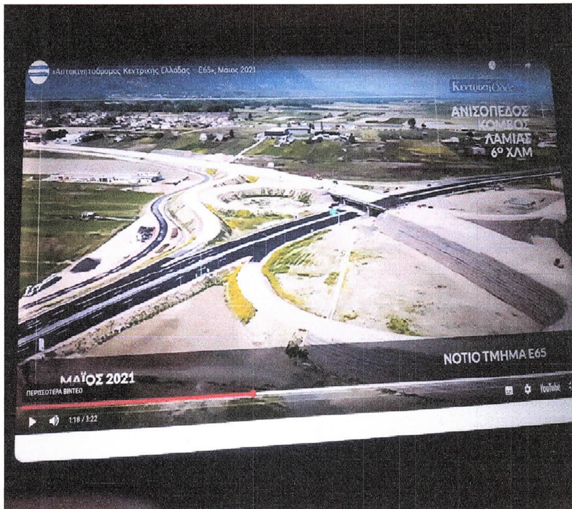
Φώτο 5: Α/Κ Λαμίας υπό κατασκευή.
