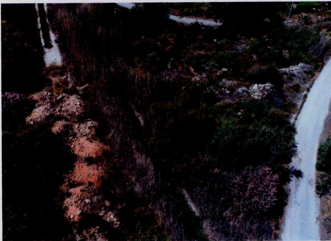
Εικόνα 5. Απόβλητα εκσκαφών και κατεδαφίσεων.
