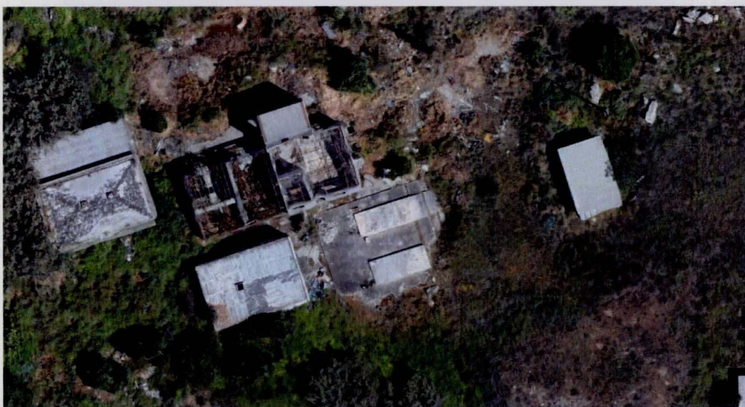
Εικόνα 11. Κατάλοιπα κτηρίων και κατεδαφίσεων στην Α' Αρχαιολογική Ζώνη
