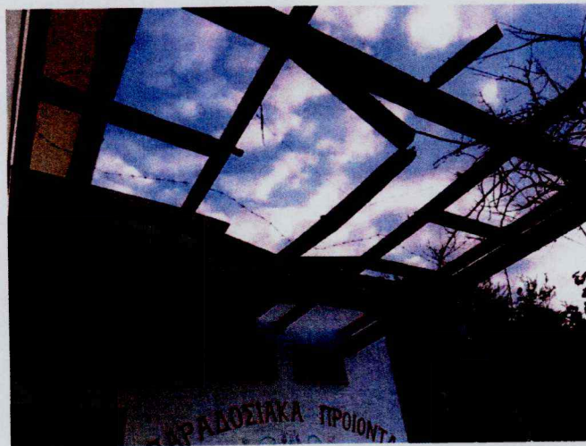
Εικόνα 1: Αντικατάσταση ξύλινης πέργκολας με τοποθέτηση νέας
