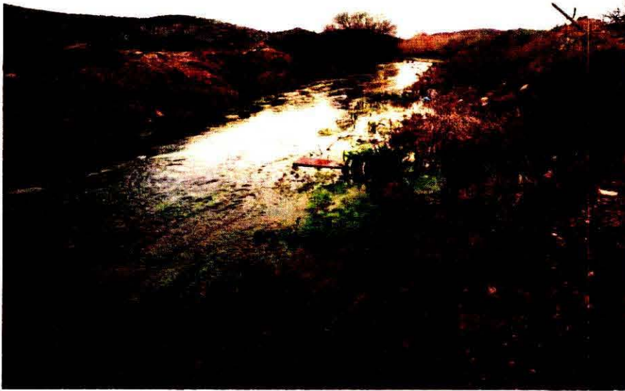
Κοίτη διαμορφωμένη πρόσφατα. Τα υλικά της εκσκαφής διαμορφώνουν το ανάχωμα της τεχνητής όχθης
