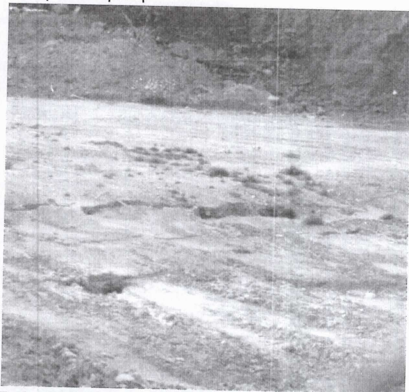
Εικόνα 4. Φωτογραφία στον ΧΥΤΑ, όπου φαίνονται οι ρωγμές στο έδαφος.
