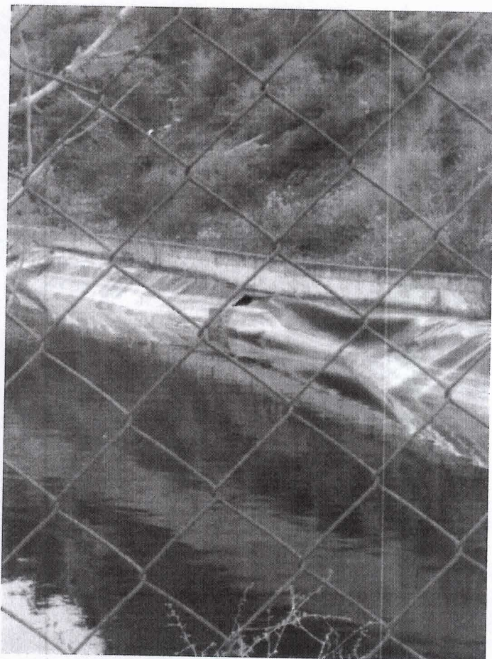
Εικόνα 6. Φωτογραφία όπου φαίνονται οι σχισμές στη μεμβράνη
