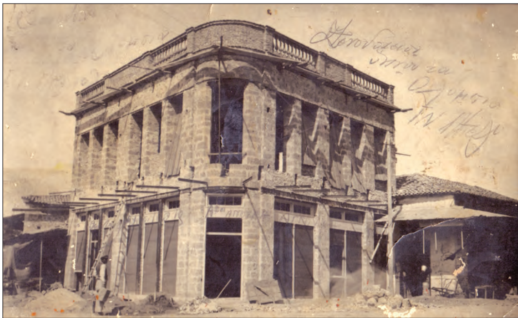
Το ξενοδοχείο «Τα Ολύμπια» κατά την κατασκευή του, στις αρχές της δεκαετίας του 1930 ΕΛΙΑ-ΜΙΕΤ, Αρχείο Έλλης Παππά
