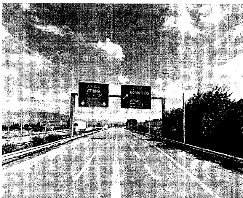
Εικόνα 2: Πινακίδα «Κόρινθος - Άργος» επί του αυτοκινητόδρομου Ελευσίνα - Κόρινθος - Πάτρα στο ρεύμα προς Αθήνα
