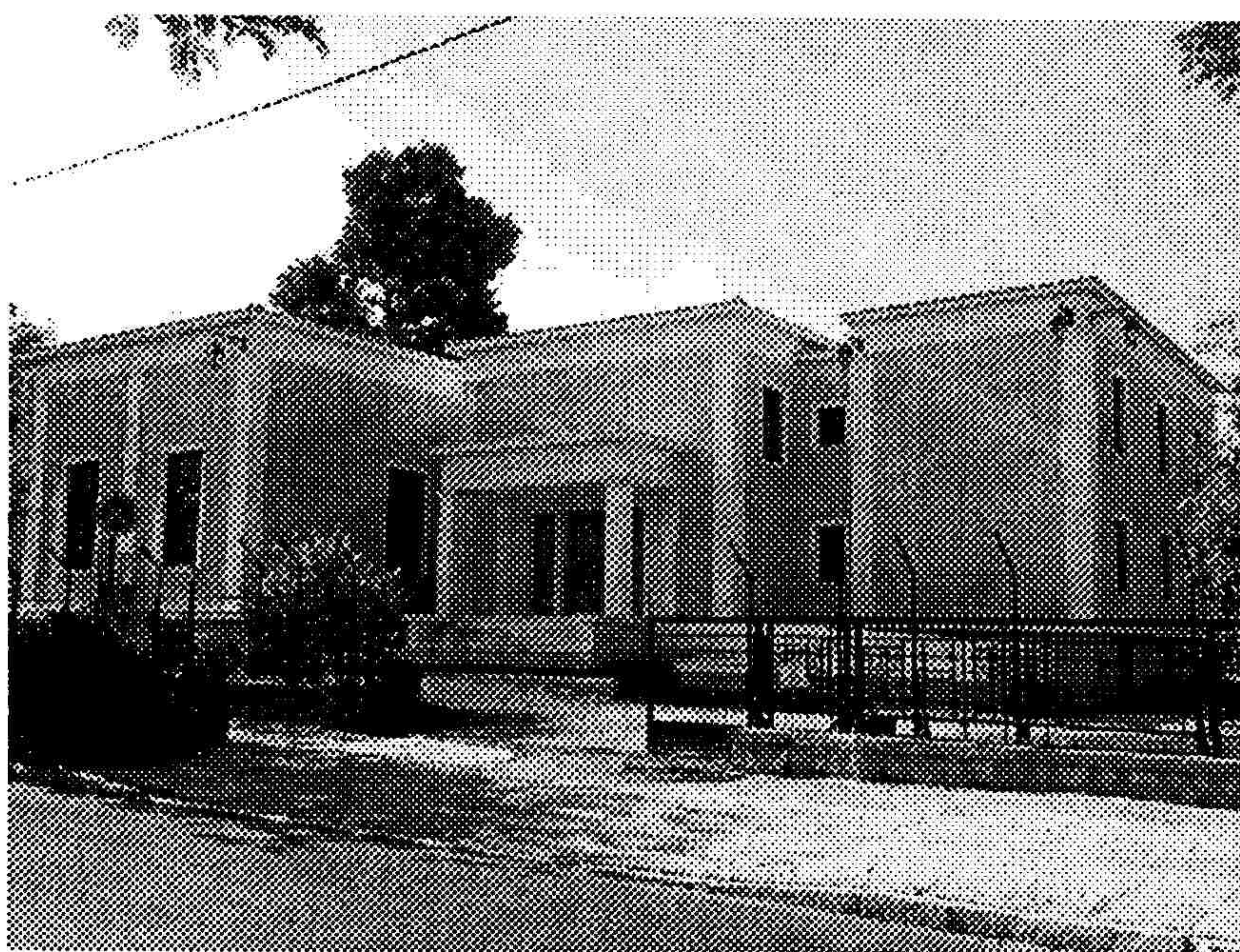
Νέο κτίριο «Συνεδριακό Κέντρο & Εστία Ψηφιακών Εκπαιδευτικών Πολυμέσων»
