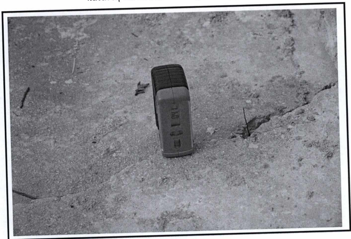
Φωτογραφία 16 Μετατόπιση ως προς την κατακόρυφο στη διάρρηξη στο πεζοδρόμιο, κατάντη και δυτικά του τοίχου στέψης .
