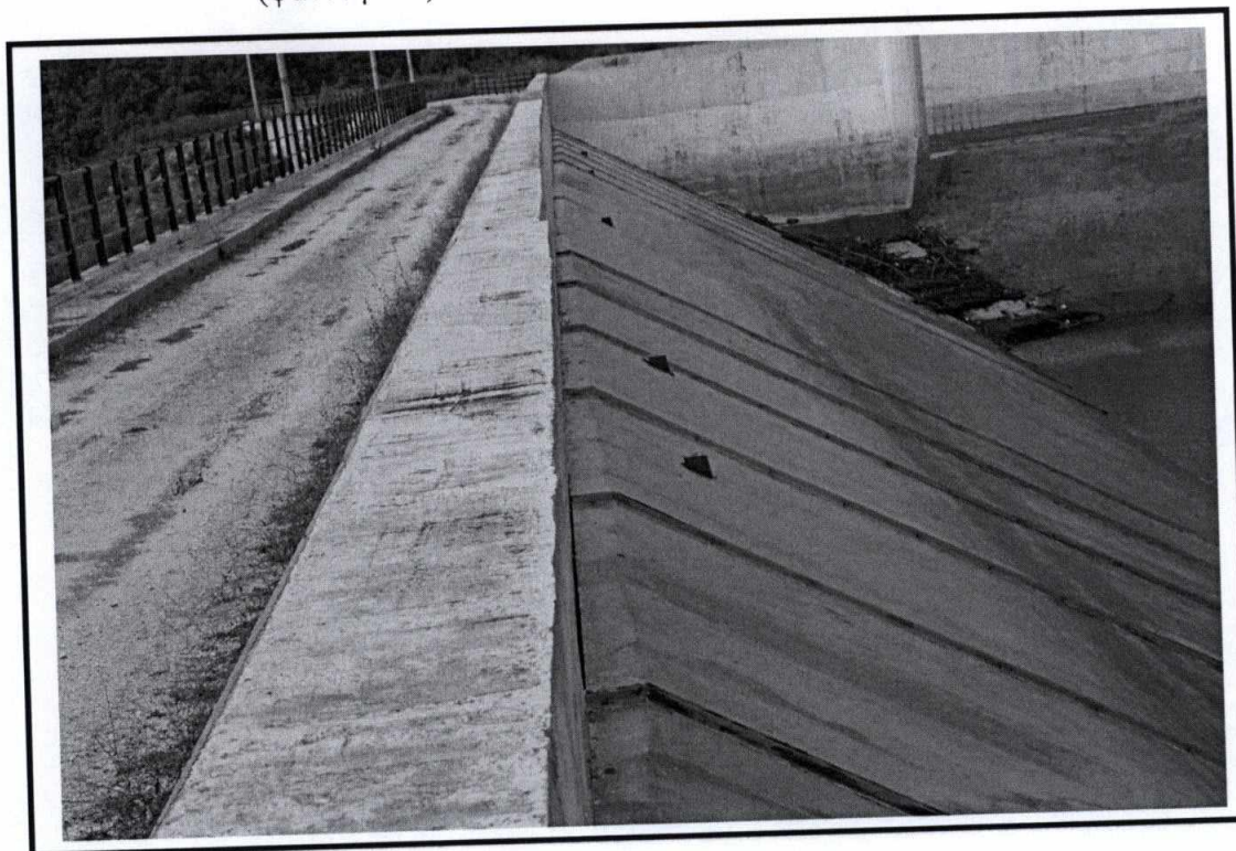
Φωτογραφία 8. Αποκόλληση του τοίχου στέψης από τις ανάντη πλάκες μπετού (φάτνωμα 2)
