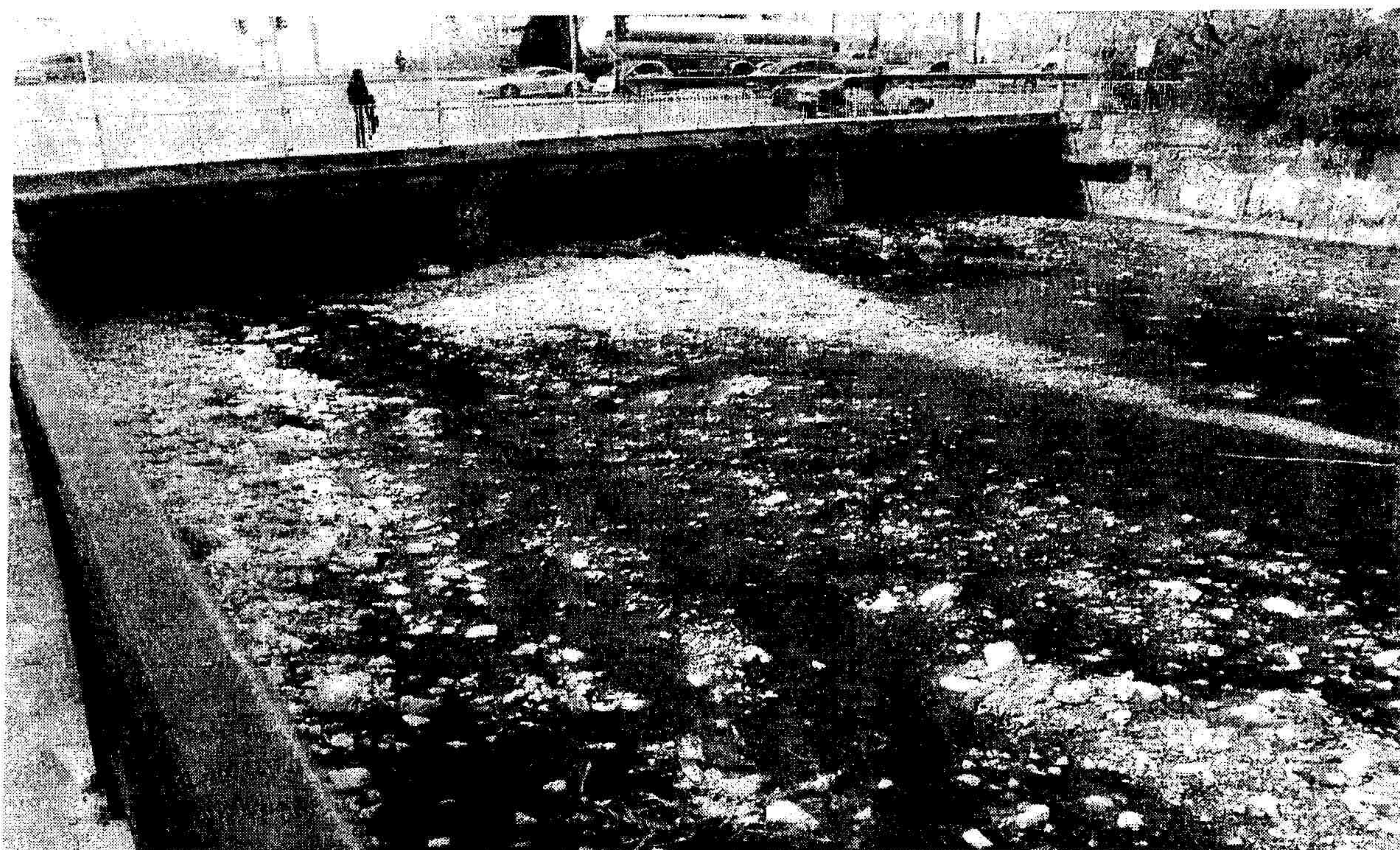
Άποψη ρέματος κατάντη αντλιοστασίου Α29 ΕΥΔΑΠ (Γέφυρα Ποσειδώνος)
