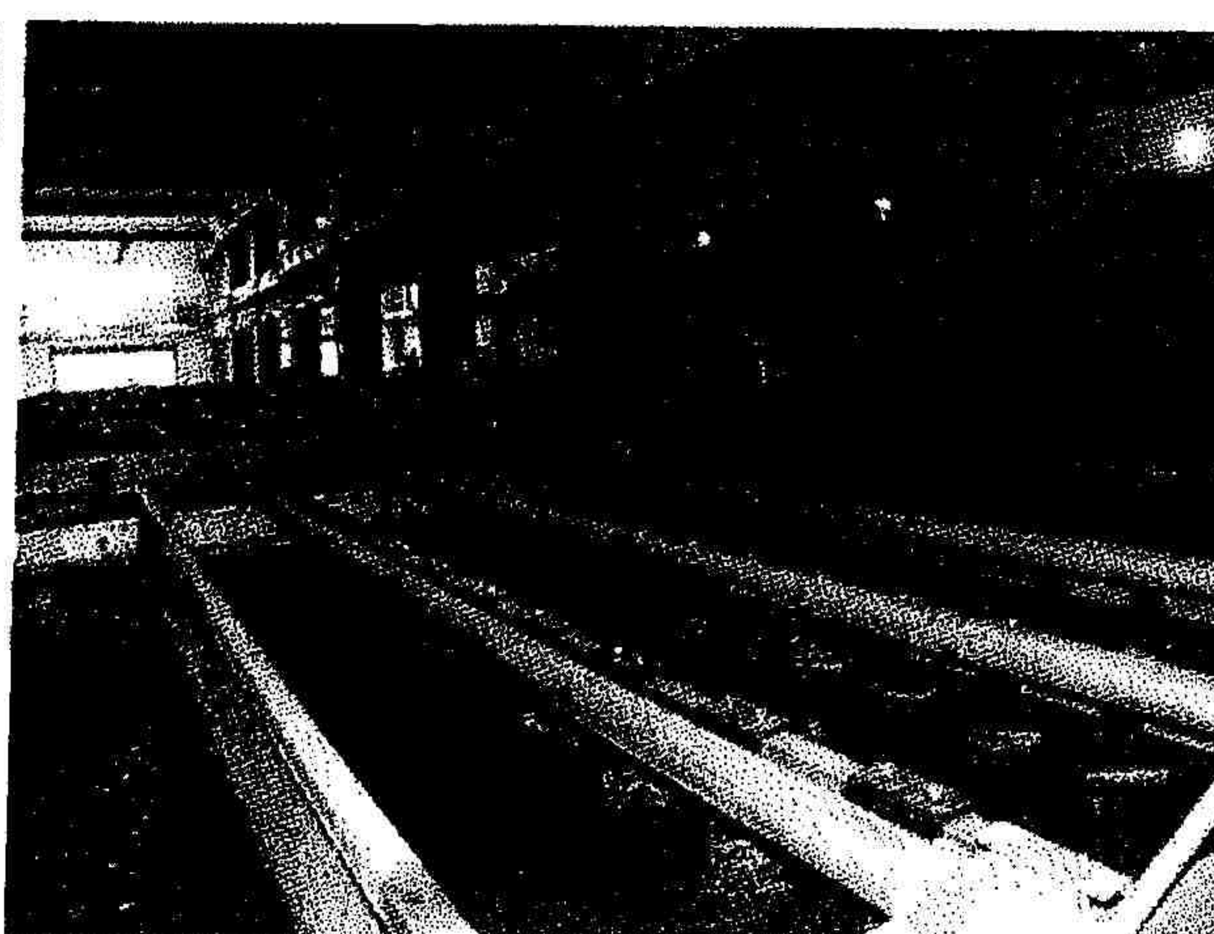
Φ.24 μηχανική πάχυνση βιολογικής λάσπης
