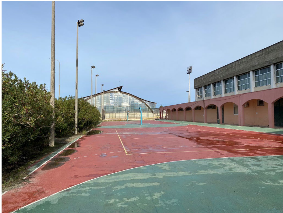
Εξωτερική όψη της εγκατάστασης με προσανατολισμό προς το βορρά και το κολυμβητήριο
