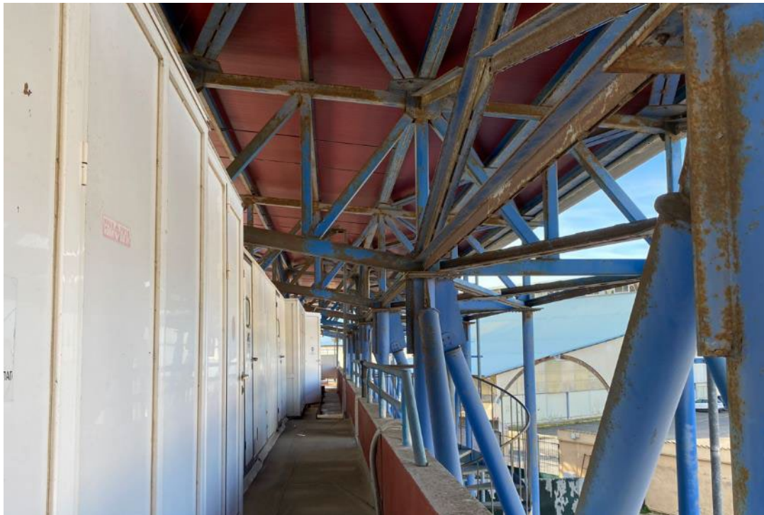
Στοιχεία οξείδωσης μεταλλικών στατικών στοιχείων στο στέγαστρο της κερκίδας
