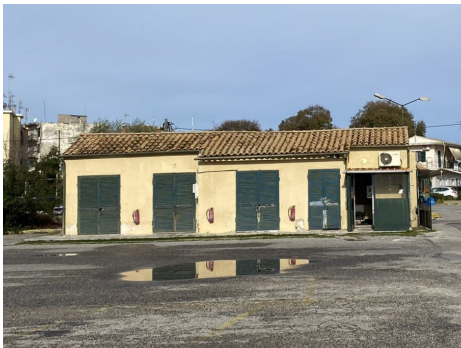
Άποψη του υποσταθμού
