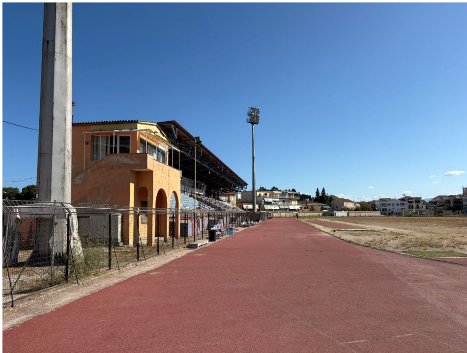
Άποψη του σταδίου και της κατεδαφιστέας κερκίδας στο δυτικό τμήμα
