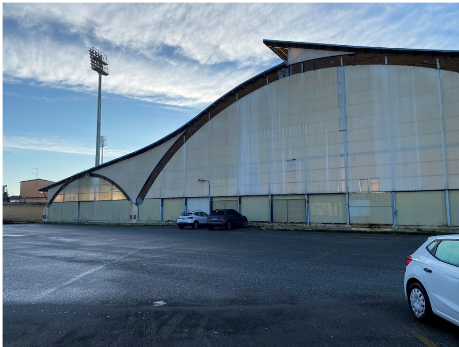
Εξωτερική βόρεια όψη κολυμβητηρίου φώτο 2023
