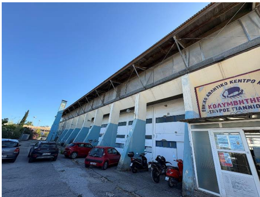
Εξωτερική δυτική όψη κολυμβητηρίου
