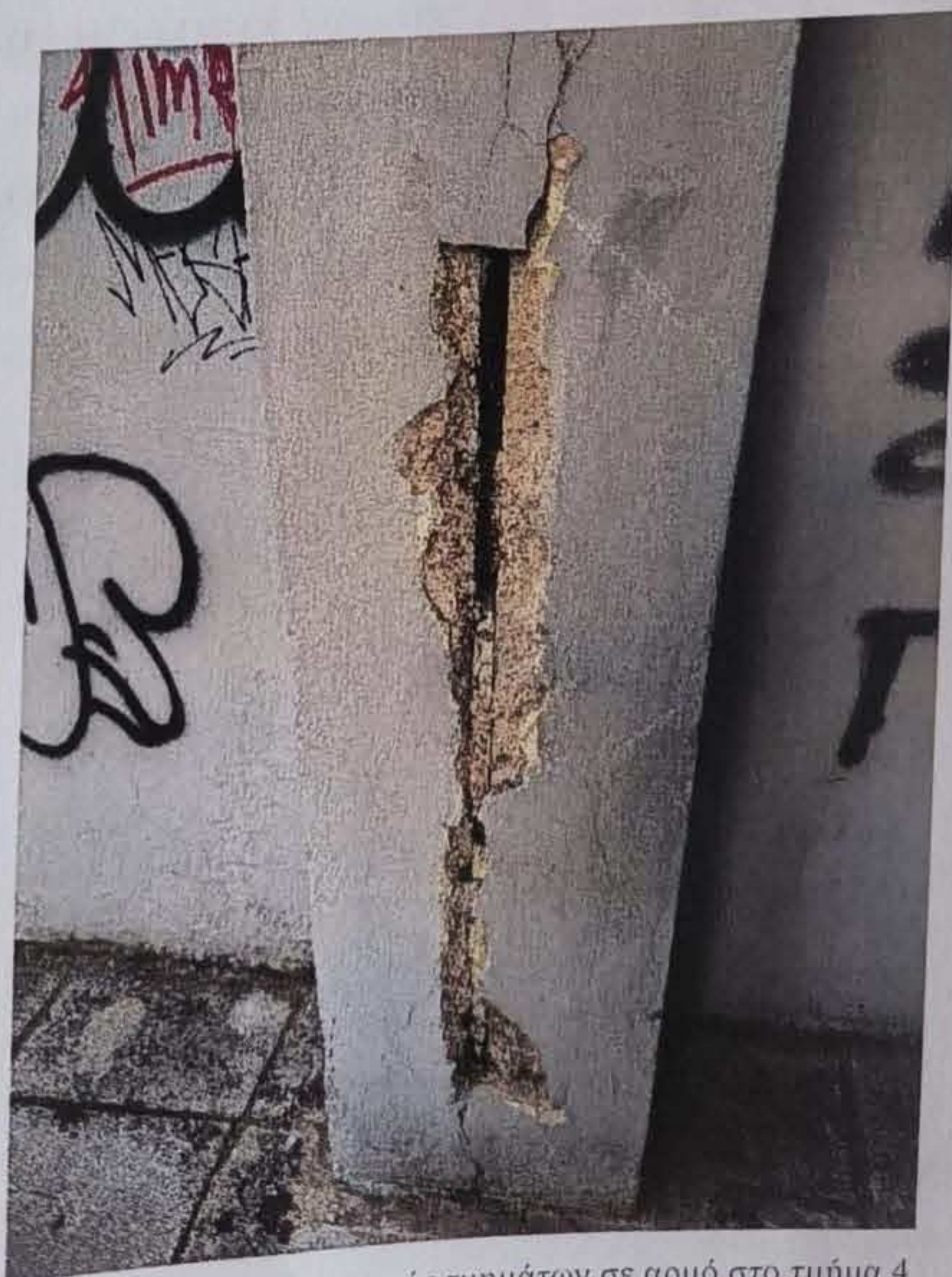
Φωτογραφία 3. Υφιστάμενη ενίσχυση υποστρώματος με σύνθετα υλικά στο τμήμα Ι
