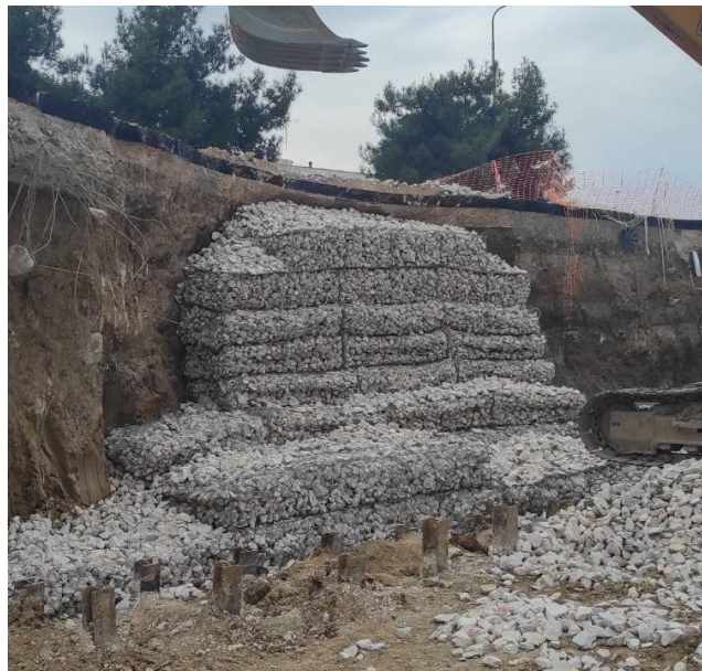
Εικόνα 1α. Μέτρα αντιστήριξης της δυτικής και ανατολικής (1β) πλευράς της γέφυρας
