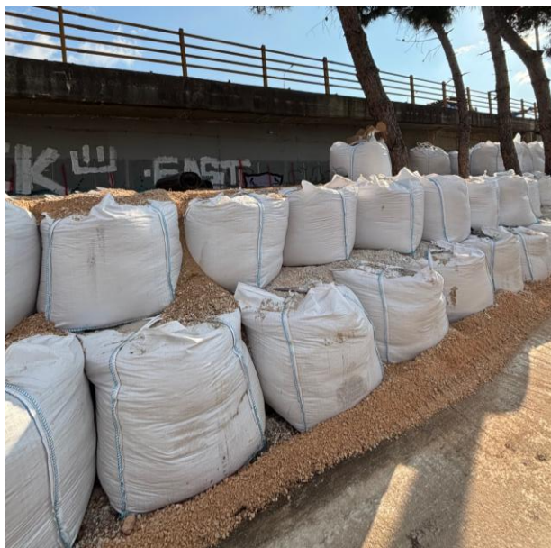
Εικόνα 1α. Μέτρα αντιστήριξης της δυτικής και ανατολικής (1β) πλευράς της γέφυρας
