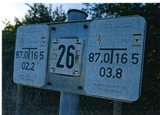
Εικόνα 2: Φωτογραφία κατά τη διάρκεια διεξαγωγής μέτρησης του μαγνητικού πεδίου στην πινακίδα (26) ένδειξης θέσης καλωδίων (Θέση 3). Η βάση είναι στο σημείο μέτρησης με α/α 11.
