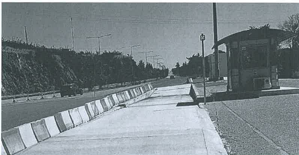
3. Σταθμός ζύγισης βαρέων οχημάτων Ευζώνων
