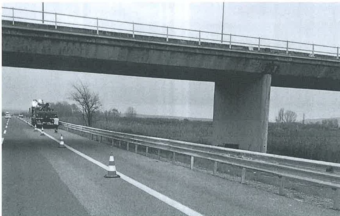
4. Εγκατάσταση Συστημάτων Αναχαίτισης Οχημάτων σε θέσεις βάθρων άνω διαβάσεων
