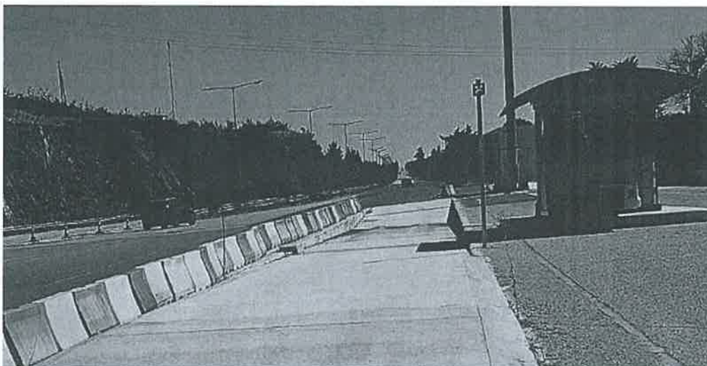
3. Σταθμός ζύγισης βαρέων οχημάτων Ευζώνων
