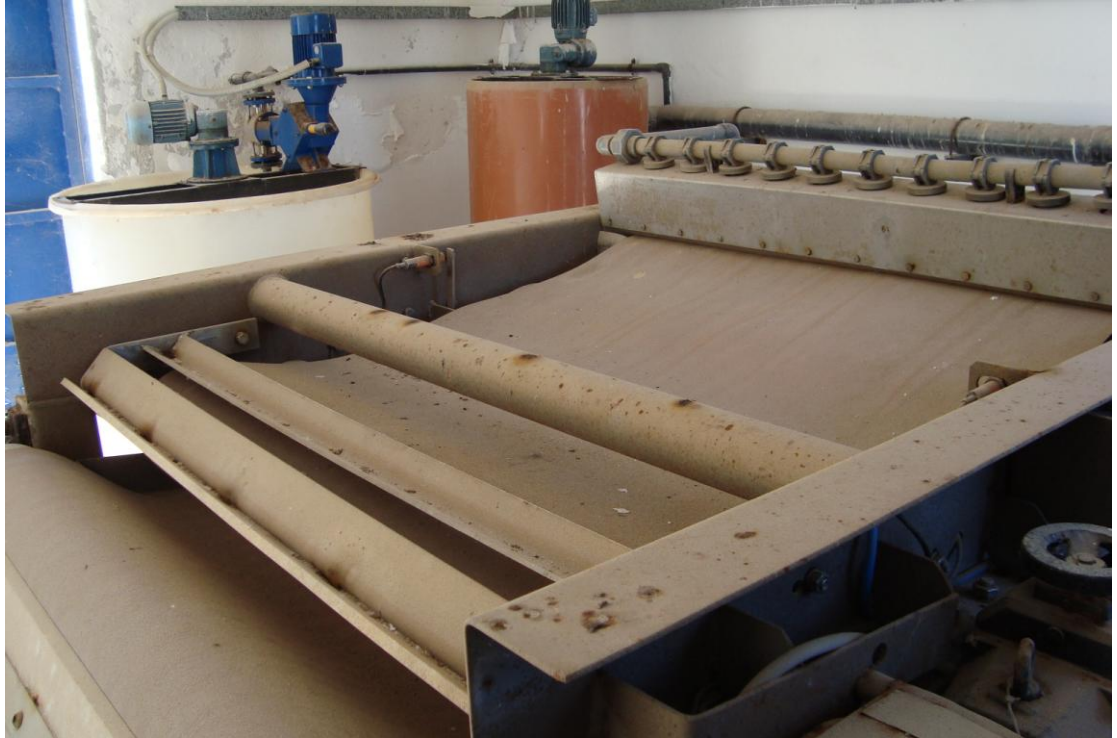
ΦΩΤΟ 12. (ειδική πρέσα λυματολάσπης σε μη λειτουργία)
