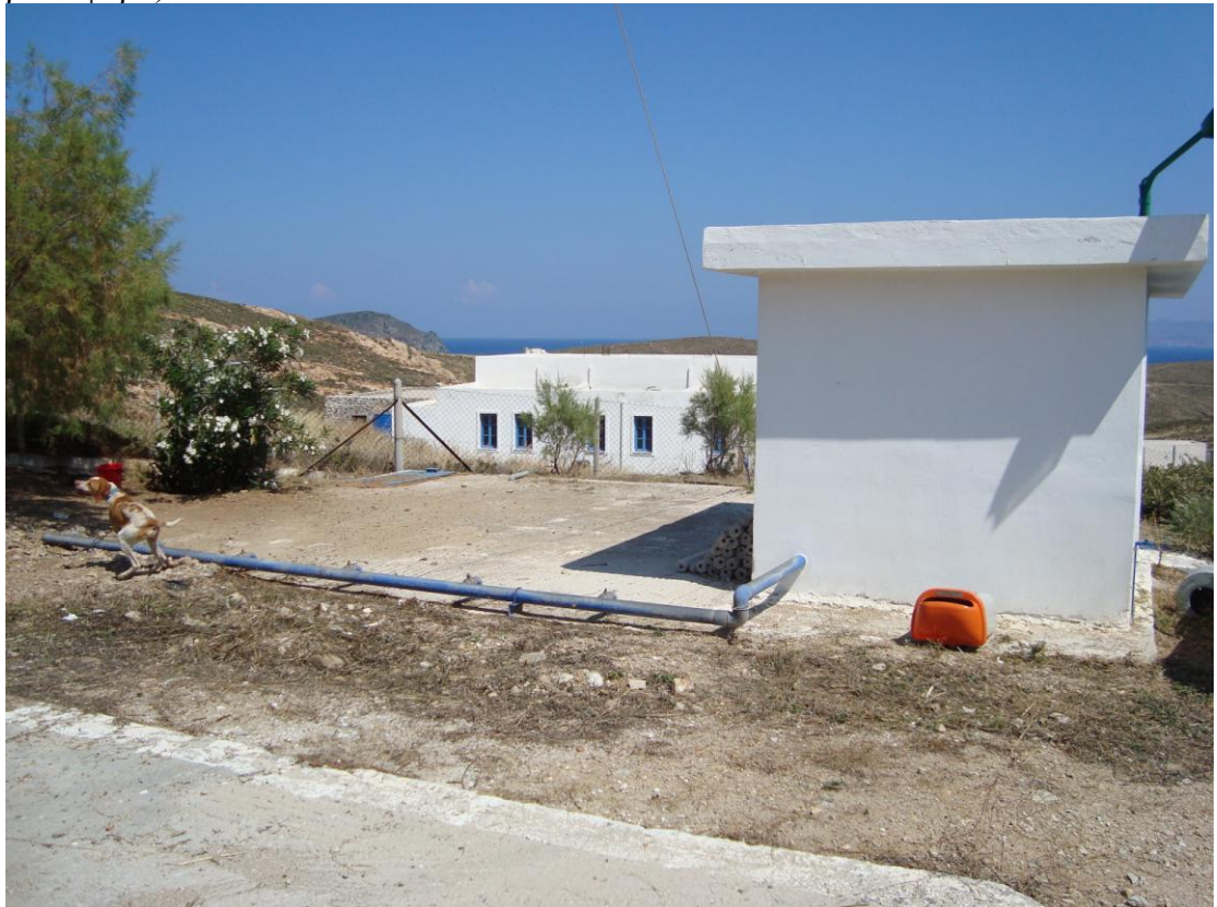
ΦΩΤΟ 4. (Δεξαμενή και αντλιοστάσιο μεταφερόμενων λυμάτων με βυτιοφόρα)
