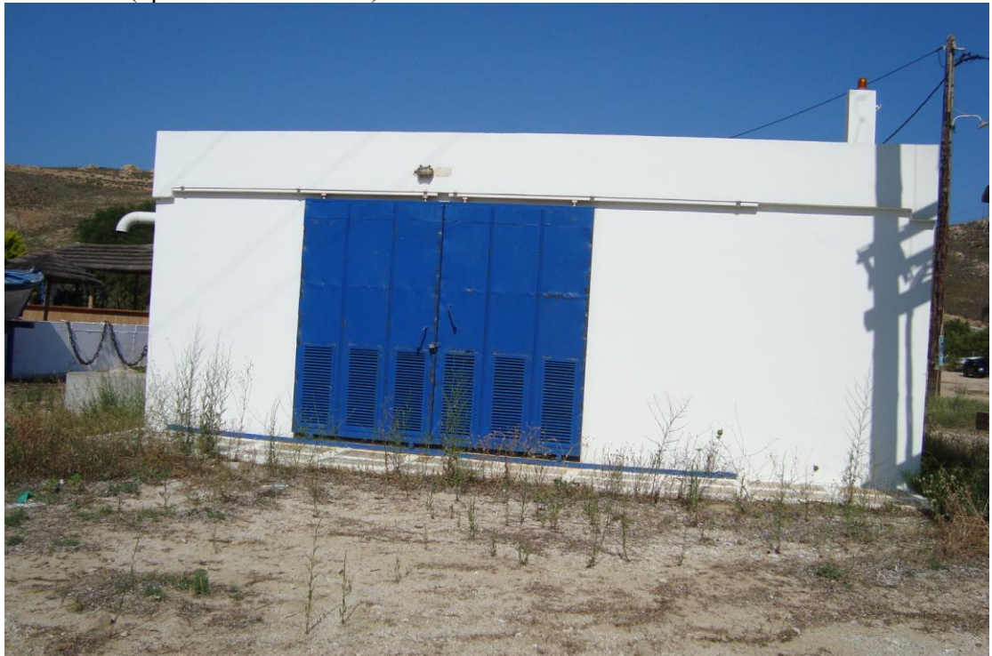
ΦΩΤΟ 1. (πρώτο αντλιοστάσιο)
