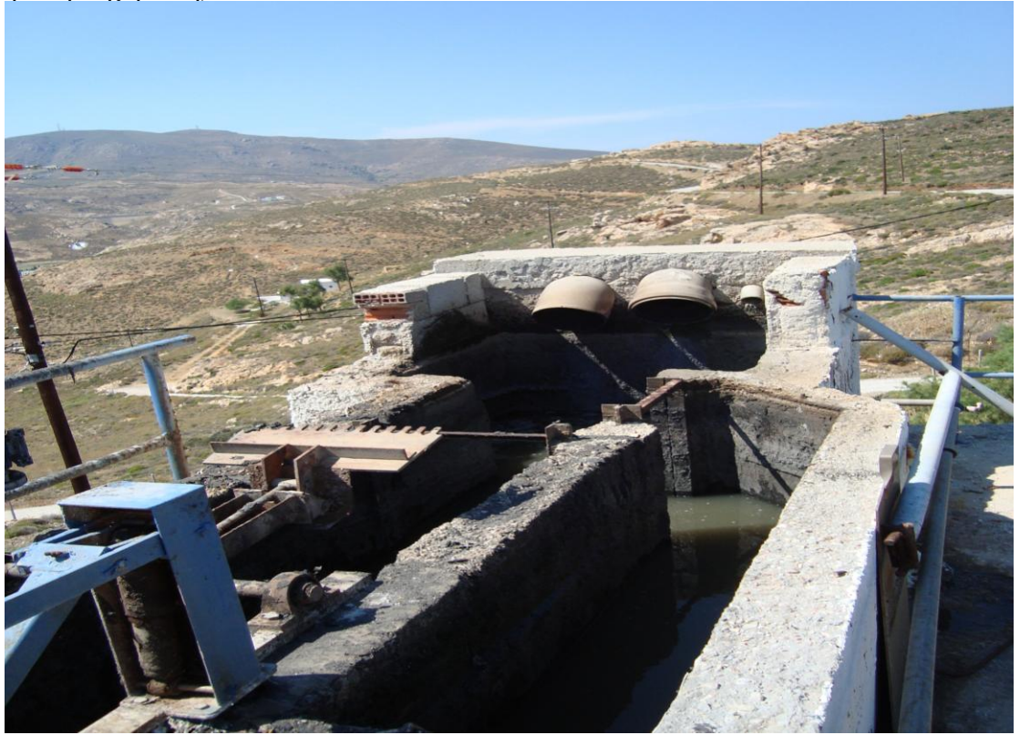
ΦΩΤΟ 6. (Αμμοσυλλέκτης, σύστημα μεταφοράς σε κάδο διάθεσης).
