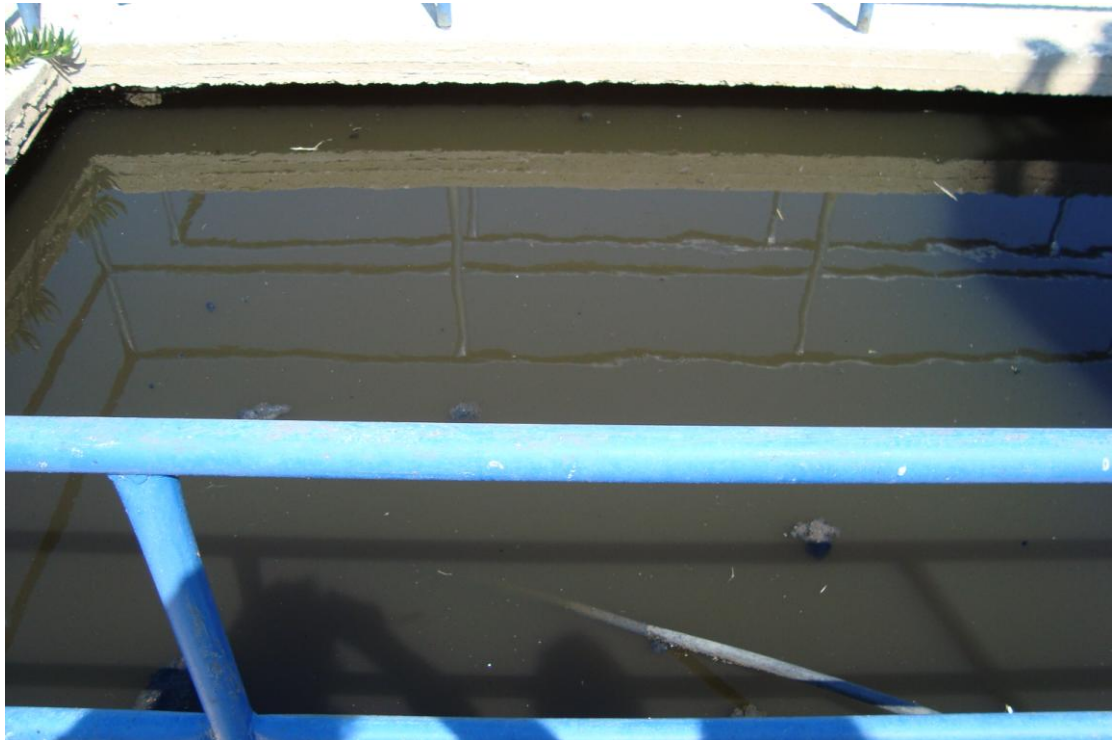
ΦΩΤΟ 18. (Δεξαμενή χλωρίωσης. Όψη επεξεργασμένων λυμάτων σχεδόν πριν την έξοδο)
