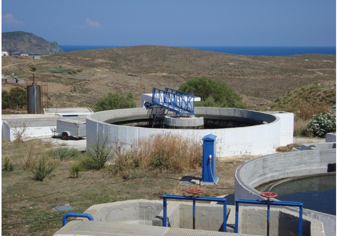
ΦΩΤΟ 10. (Δεξαμενή καθίζησης σε συντήρηση)
