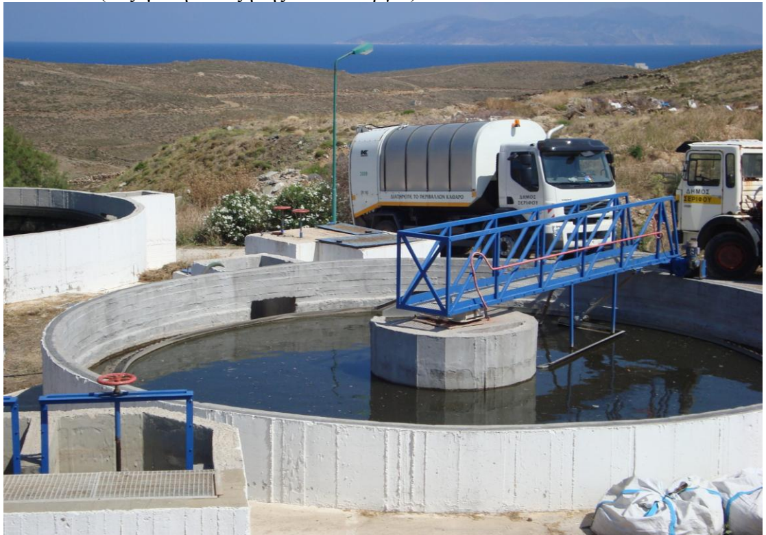
ΦΩΤΟ 9. (δεξαμενή καθίζησης εν λειτουργία)
