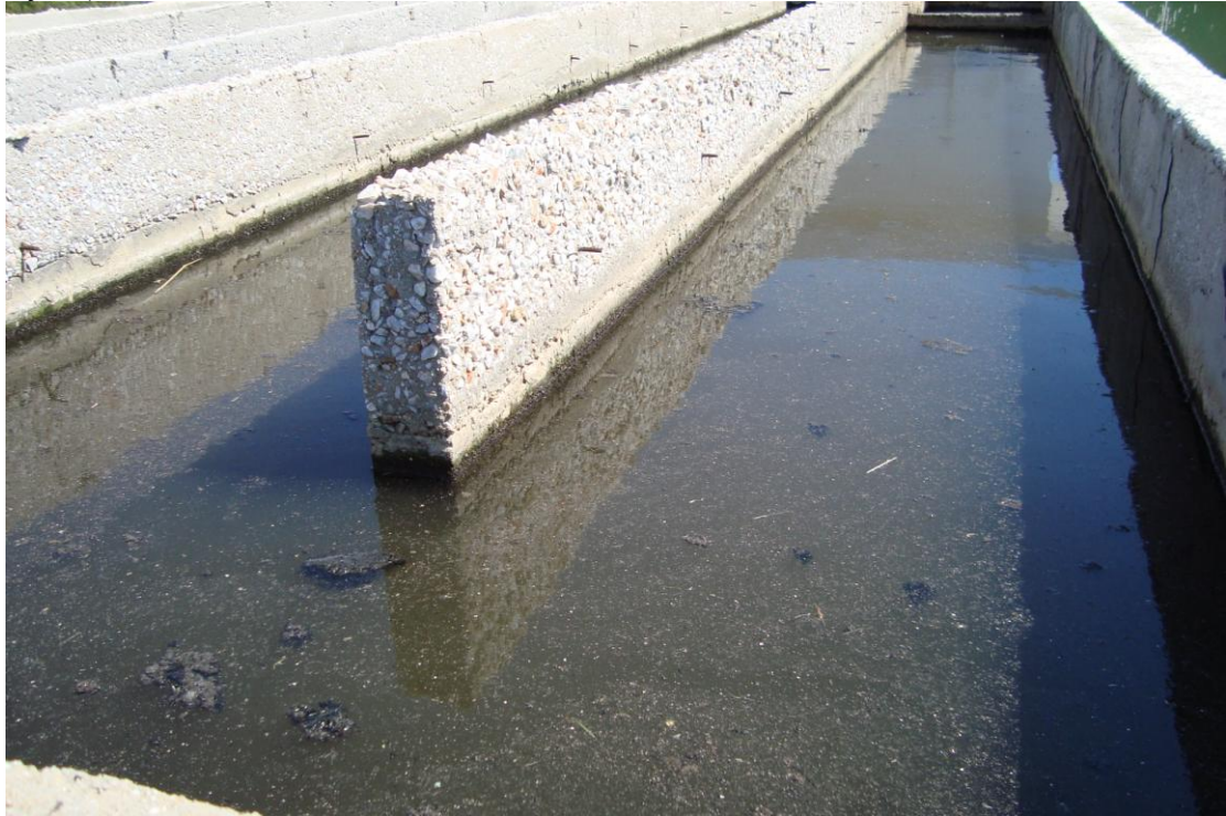
ΦΩΤΟ 18. (Δεξαμενή χλωρίωσης. Όψη επεξεργασμένων λυμάτων σχεδόν πριν την έξοδο)
