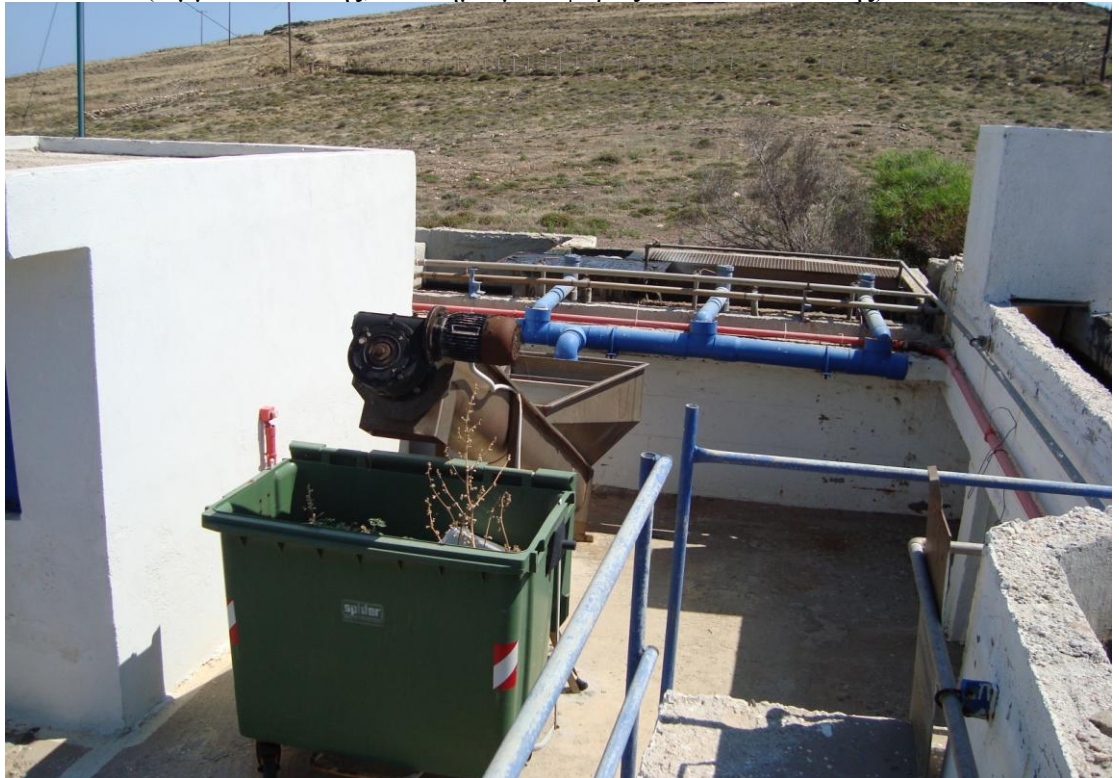
ΦΩΤΟ 6. (Αμμοσυλλέκτης, σύστημα μεταφοράς σε κάδο διάθεσης).
