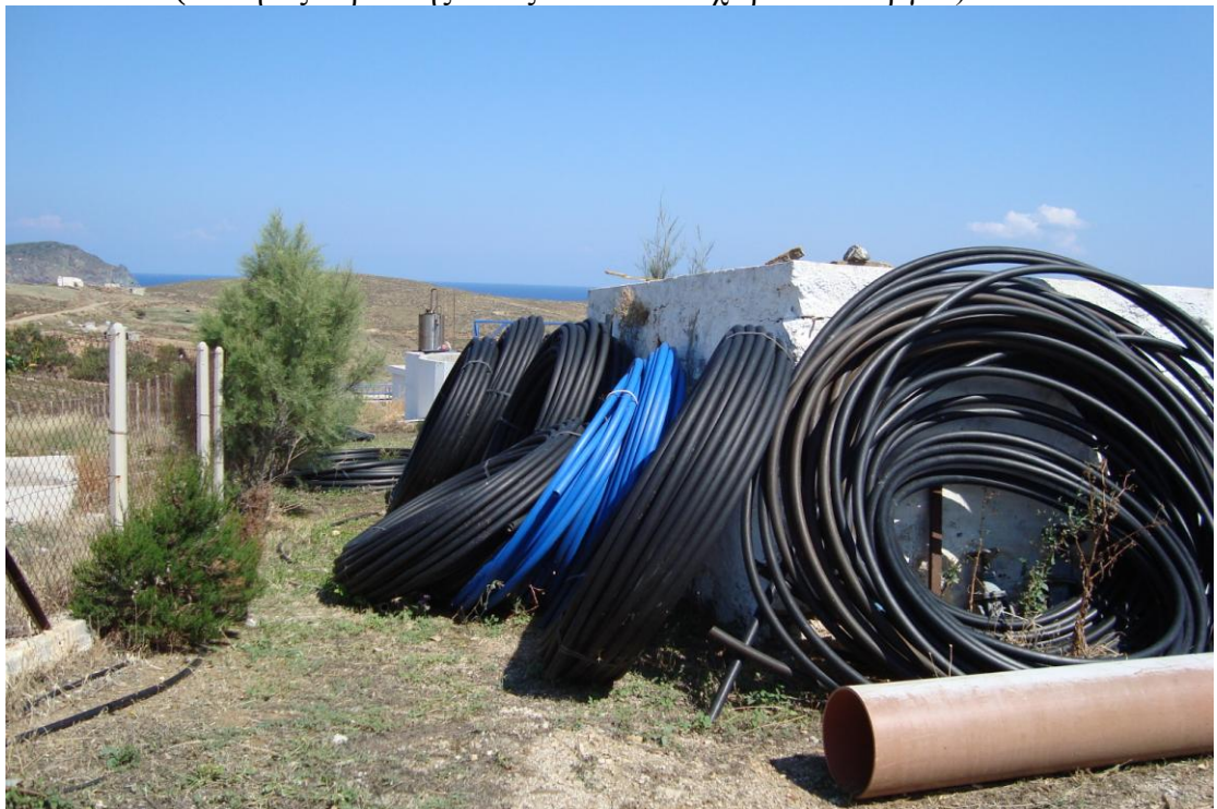
ΦΩΤΟ 28. (Σωλήνες ύδρευσης εντός ακάλυπτων χώρων του έργου)
