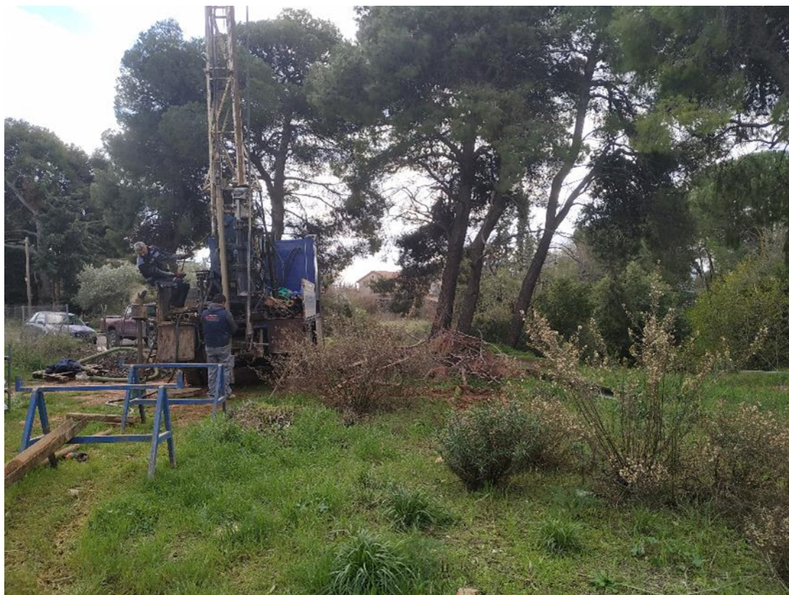
ΘΕΣΗ ΓΕΩΤΡΗΣΗΣ ΓΝ4 (ΟΔΟΣ ΤΥΜΦΡΗΣΤΟΥ). ΗΜΕΡ. ΔΙΑΤΡΗΣΗΣ 21-22/12/2021
