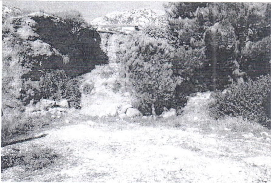
Εικόνα 4- Καταπτώσεις πρηνών εντός οικισμού Αστακού
