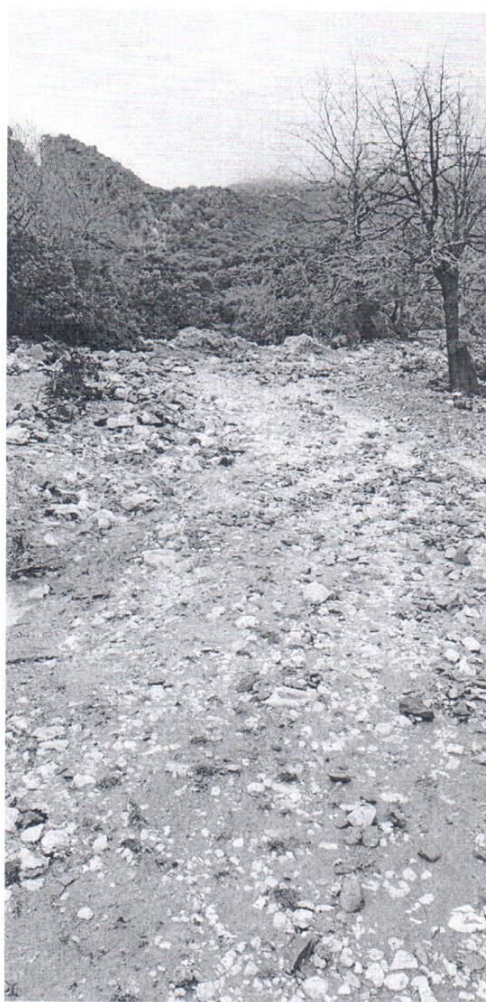
Εικόνα 6- Ολοκληρωτική καταστροφή αγροτικής οδοποιίας
