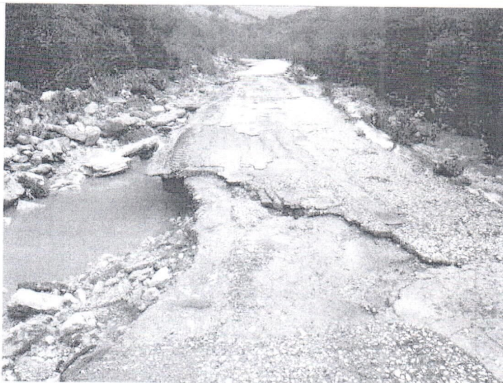
Εικόνα 1- Αγροτική οδοποιία Δήμου Ξηρομέρου (τμήμα 4 χιλιομέτρων)
