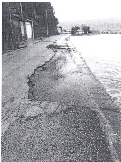
Εικόνα 1- Λιμάνι Τ.Κ. Αστακού
