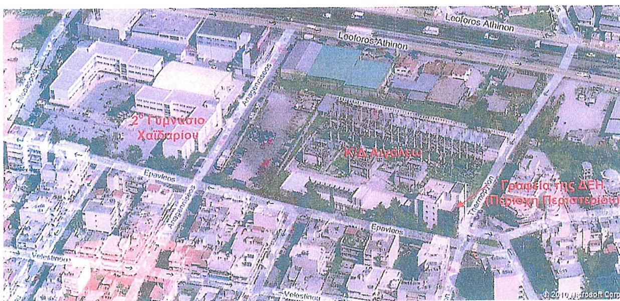
Εικόνα 1. Κέντρο Διανομής 150/20 kV Αιγάλεω.
