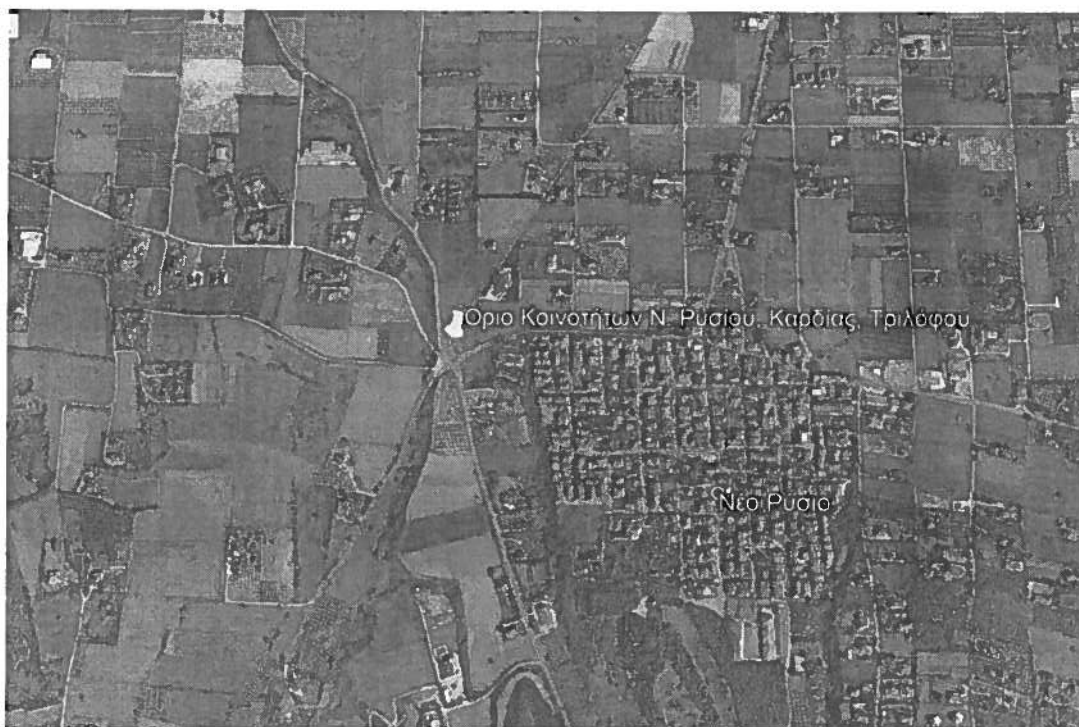
Εικόνα 5: Αεροφωτογραφία του κόμβου στο όριο των Κοινοτήτων Καρδίας-Ν. Ρυσίου και Τριλόφου [Πηγή: Google Earth Pro]
