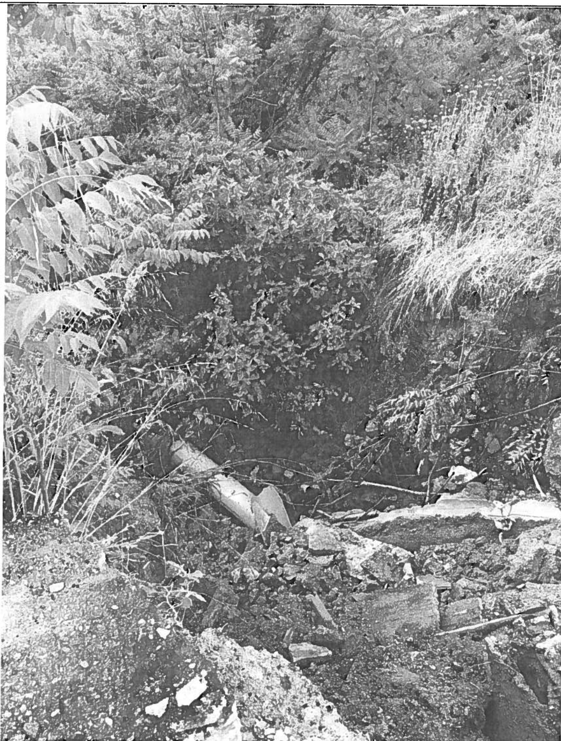
Εικόνα 2.1.8. Τονίζεται ότι η κλίση του πρανούς είναι περίπου 4 (κ) : 1 (ο) και η στάθμη που αποτυπώνεται στο χαμηλότερο σημείο στην παρούσα εικόνα είναι περίπου -30.0μ. από το κατάστρωμα.
