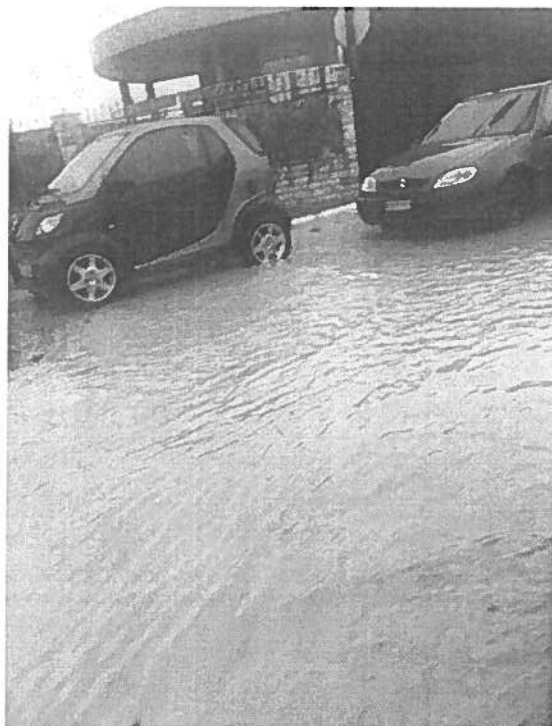
Εικόνα 24: Πλημμυρισμένος δρόμος λόγω υπερχείλισης ρέματος πίσω από οικισμό ΧΡΩΜΑ
