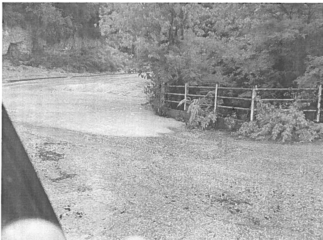
Εικόνα 8: Γέφυρα στο ρέμα Καρδαράς επί της οδού Καρδίας
