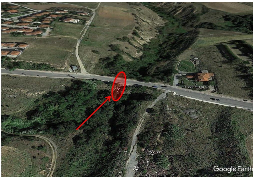
Εικόνα 2.1.2. Αποτύπωση θέσης αστοχίας με χρήση Google Earth (ημερομηνία εικόνας 9/7/2017).
