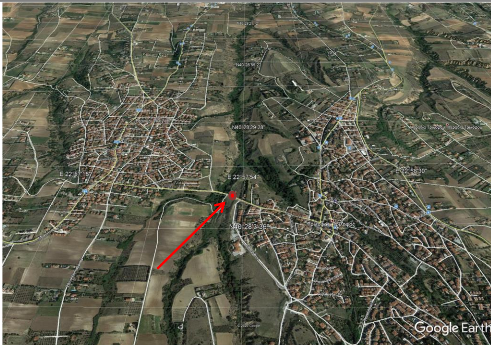
Εικόνα 2.1.1. Αποτύπωση θέσης αστοχίας με χρήση Google Earth (ημερομηνία εικόνας 9/7/2017).
