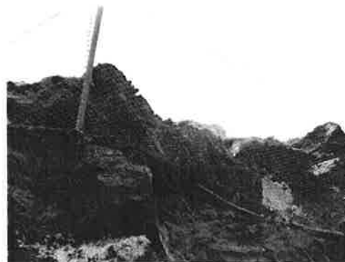
Εικόνα 16. Κενό στη βάση του φράχτη λόγω κακής εφαρμογής αυτού, το οποίο θα πρέπει να κλείσει (Μονοπάτι πρόσβασης προς Όρμο Αρμενίου)
