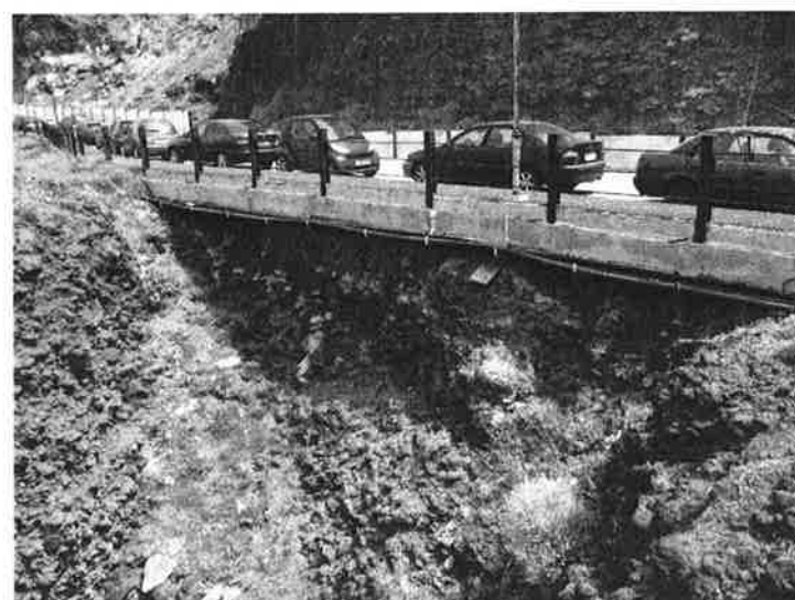
Εικόνα 9. Καλύτερες συνθήκες θεμελίωσης του δρόμου (Θέση 6)
