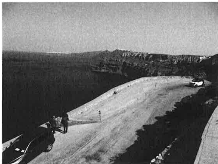
Εικόνα 2. Άποψη αστοχίας στη Θέση 1 από ανάντη
